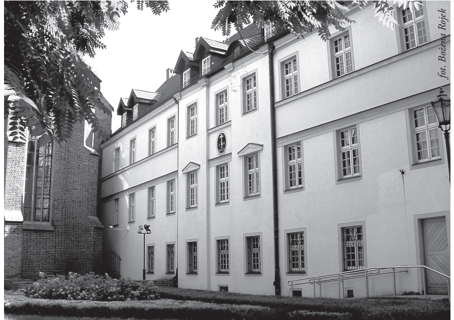
Budynek dawnej plebanii parafii pw. Najświętszego Imienia Jezus, obecnie należy do Zakładu Narodowego im. Ossolińskich
